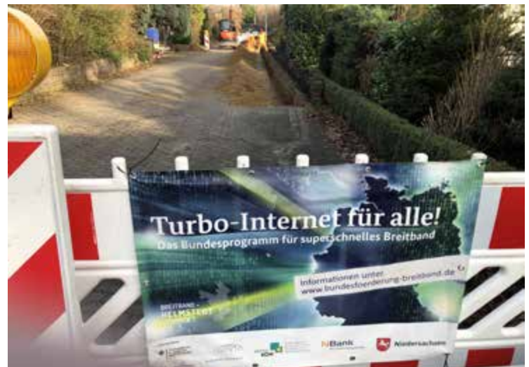
Der Breitband- ausbau in Boimstorf.
